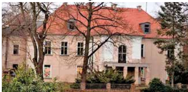
15518 Steinhöfel, OT Heinersdorf, Hauptstraße 36c
