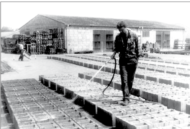
BHG-Gelände mit Herstellung von Betonsteinen
