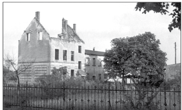
Das ehemalige Bauerngelände nach 1945 am Rande der Ortschaft (Frankfurter Straße)
