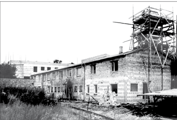
1969 Bau des Gebäudes der BHG mit Verkaufsstelle
